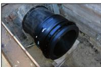
Unser Vertriebspartner [STAR](#) fertigt seit vielen Jahren bereits E-Muffen und E-Formteile von SDR 7,4, - SDR 11 bis zur Abmessung d 1.400mm. Sonderbauteile, die Sie in unserem Standardprogramm nicht finden, fertigen wir für Ihre Anwendung individuell an. Im Bild zu sehen ist eine Kombination aus einem Vorschweißbund mit Flansch mit werkseitig angeformter E-Muffe in einer Rohrsonderabmessung außen d 1.020mm.
